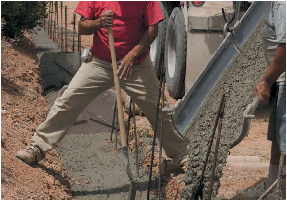
Рис. 6. Фундамент «в грунт»
