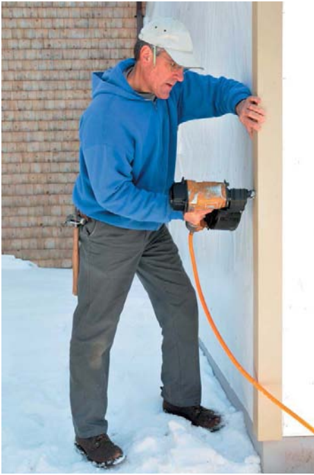
Рис. 42. Крепление углового элемента
