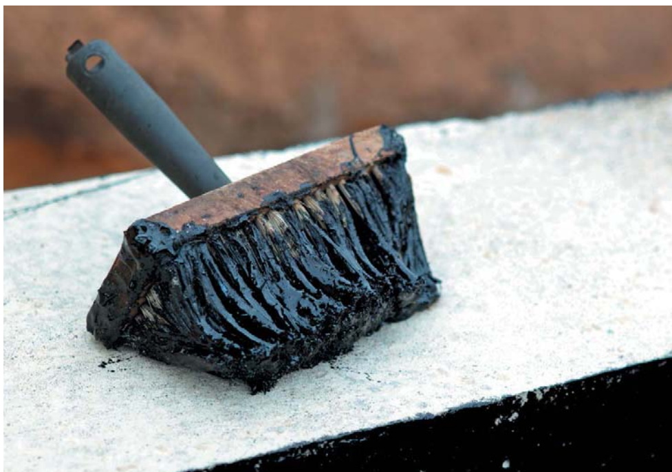
Рис. 8. Обмазочная гидроизоляция фундамента
