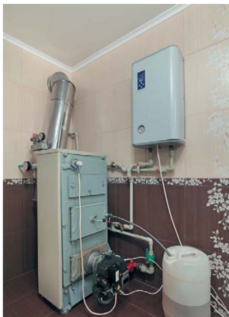
Рис. 36. Комбинированный котел, работающий на дизельном и твердом топливе
