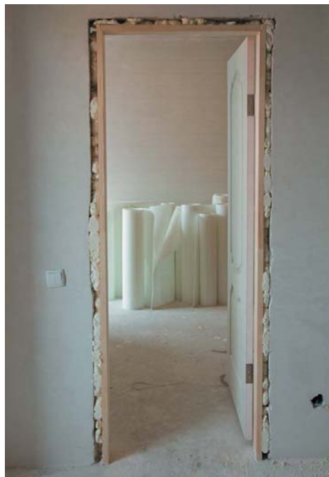
Рис. 25. Заполнение зазоров монтажной пеной
