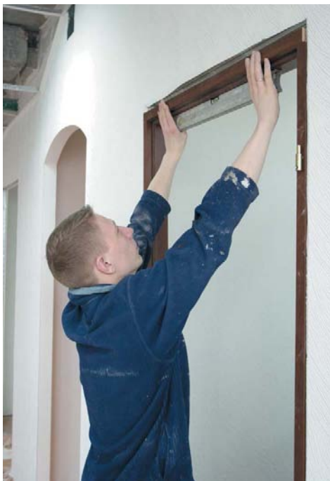
Рис. 24. Проверка вертикальности дверной коробки
