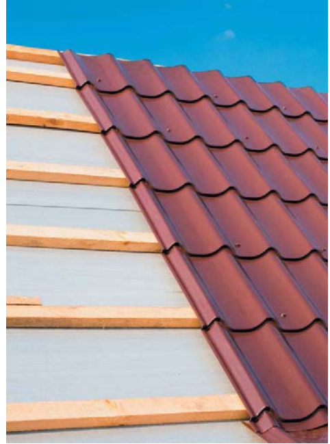
Рис. 17. Кровля из металлочерепицы
