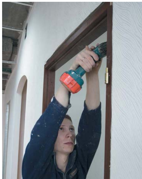
Рис. 23. Крепление дверной коробки в проеме
