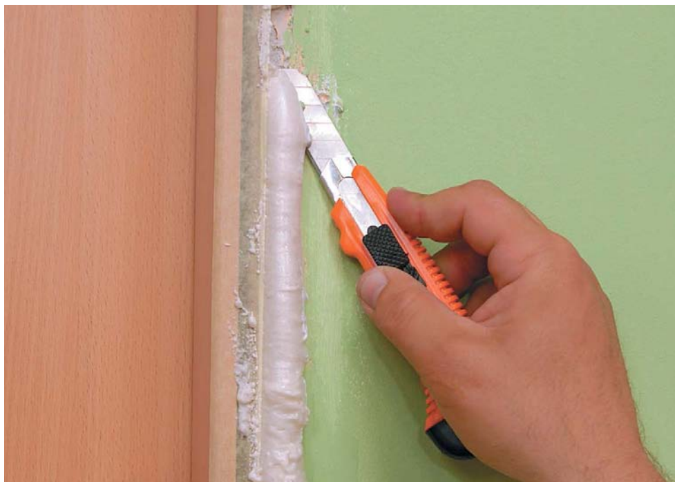
Рис. 26. Удаление излишков затвердевшей пены
