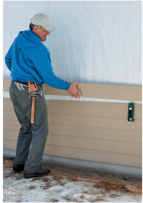
Рис. 43. Установка очередных ламелей
