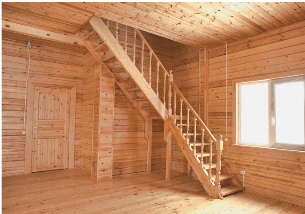
Рис. 28. Деревянная лестница в доме из бруса
