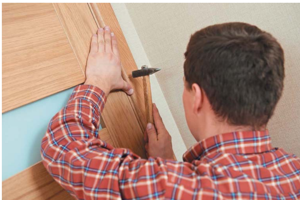
Рис. 27. Установка наличников
