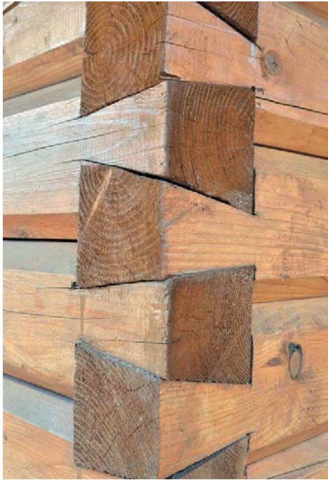
Рис. 11. Брус со снятыми фасками
