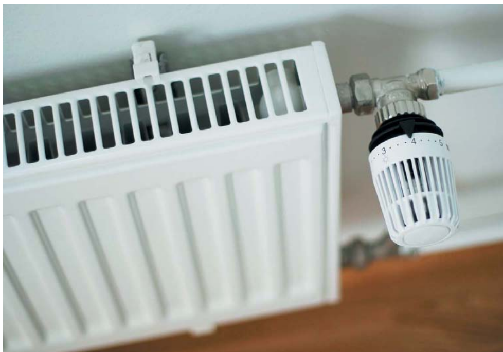
Рис. 39. Стальной панельный радиатор
