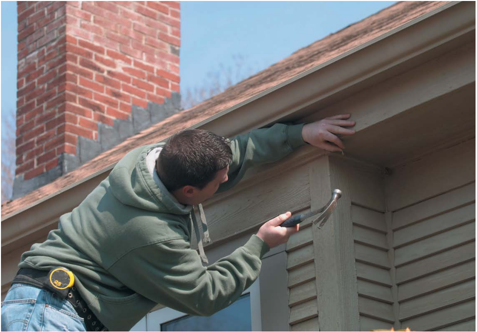
Рис. 44. Завершение монтажа сайдинга
