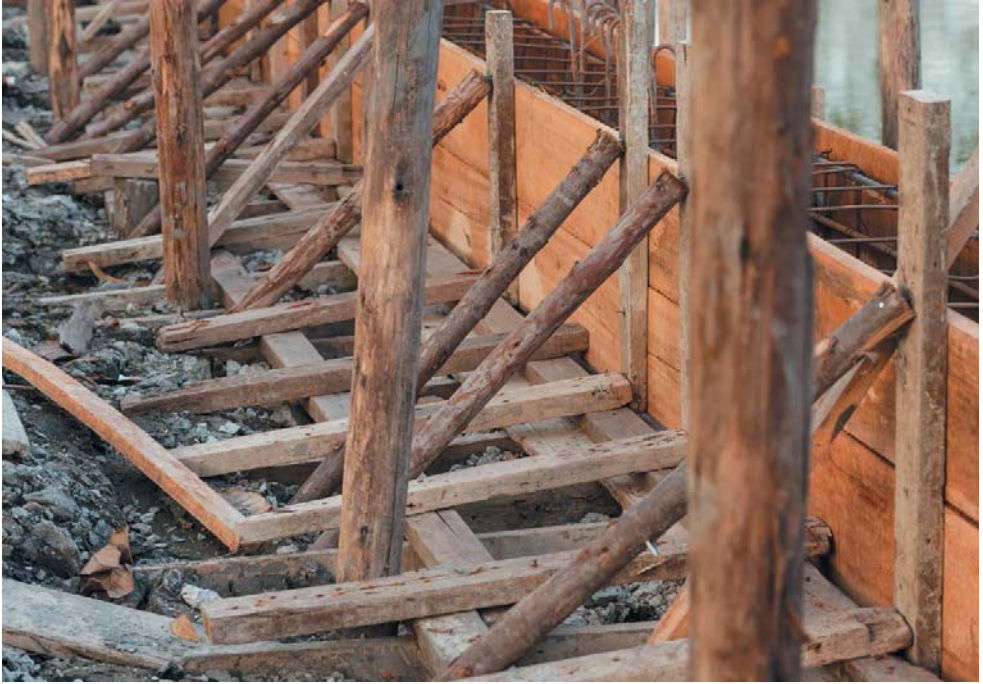
Рис. 5. Опалубка ленточного фундамента
